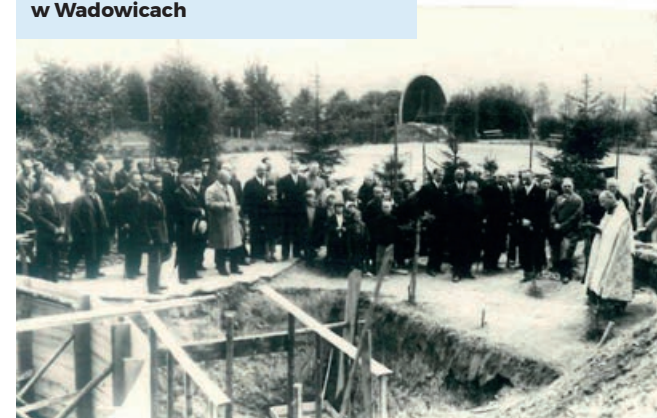
Budowa zbiornika wyrównawczego w Parku Miejskim, Muzeum Miejskie w Wadowicach
